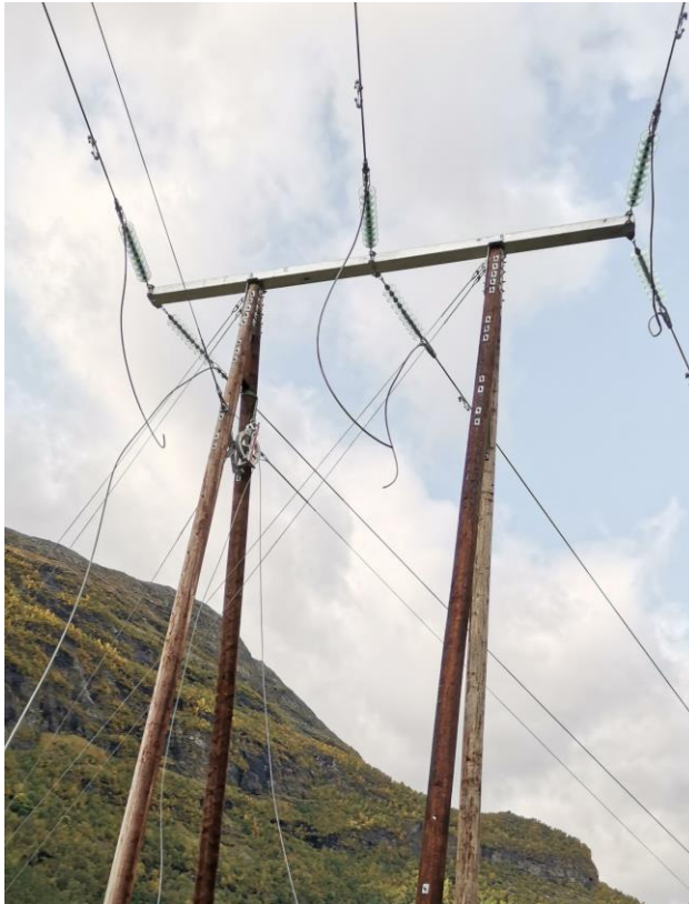
Fig.1 FM forankr.mast 132 kV under oppføring med underliggende OPGW og vibrasjonsdempere (glassisolatorer erstattes av komposittisolatorer i dette prosjekt)
